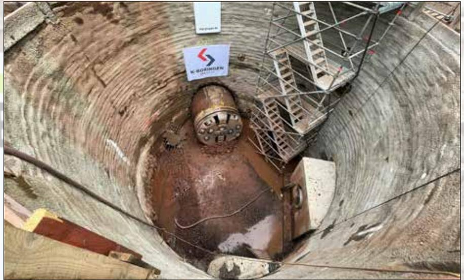
Durch den Vortrieb entstand ein Stauraumkanal mit 3.400 m<sup>3</sup> Rückhaltevermögen.
